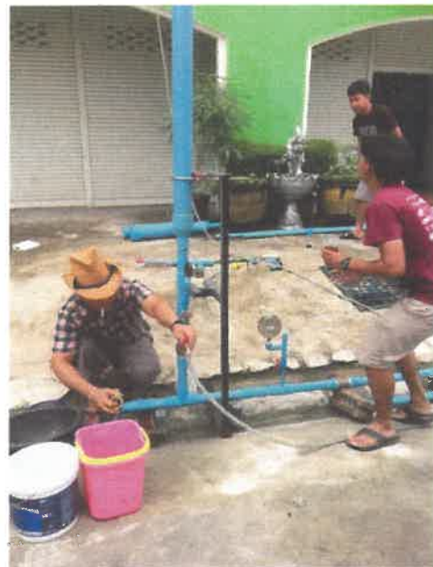
ภาพที่ 3 การติดตั้งถังอัดอากาศ
